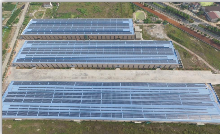
兰溪三江开源2.85MW
